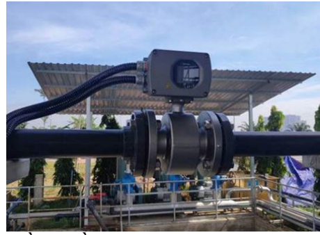
b. Đồng hồ đo lưu lượng nước thải từ máy Wash
