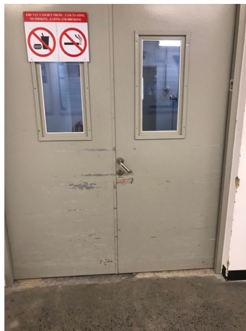
Hình 3.18 Hình ảnh một số khu vực lưu chứa chất thải rắn thông thường tại nhà xưởng số 1, Lô I-3B-1
