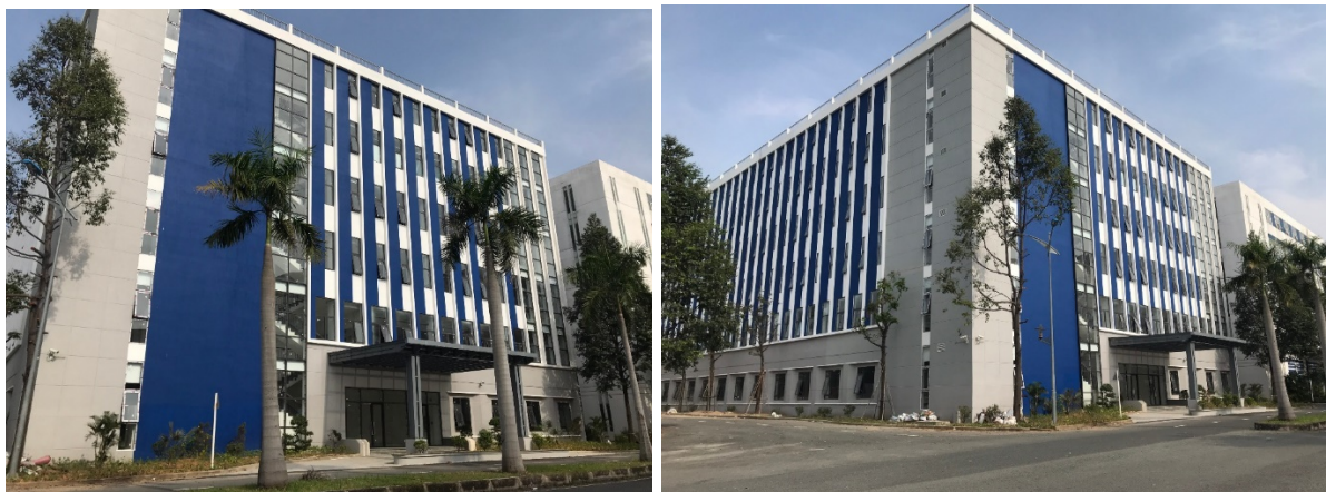
Hình 1.6 Hiện trạng khu vực nhà xưởng Lô I-3B-1, nhà xưởng số 1, KCNC, phường Tân Phú
