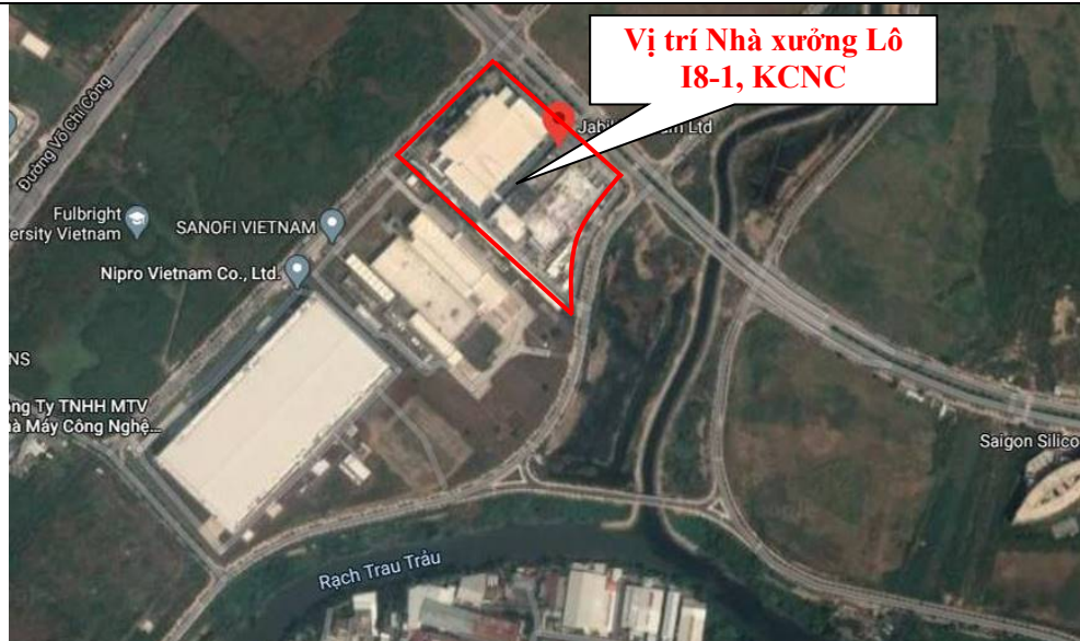
Hình 1.1 Hình ảnh Nhà xưởng Lô I8-1, KCNC, phường Long Thạnh Mỹ, Tp. Thủ Đức trên bản đồ Google Map
