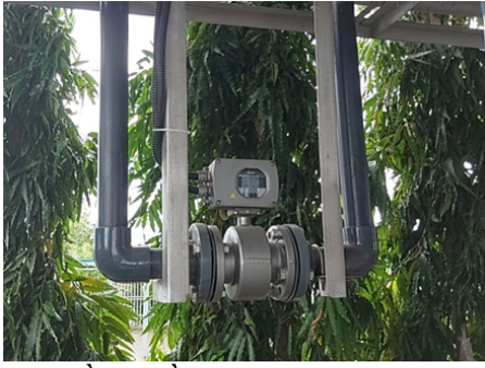
a. Đồng hồ đo lưu lượng nước thải sau xử lý
