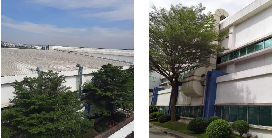
Hình 3.11 Ống khói thải Khu Nhà xưởng B1
