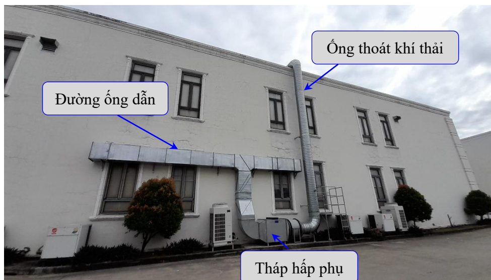
Hình 3.5 Hình ảnh về hệ thống xử lý khí thải số 1.
