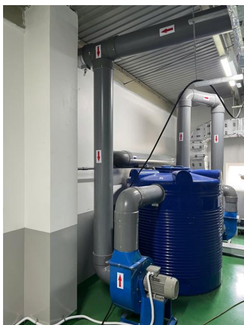
Hình 3. 10. Hình ảnh Hệ thống xử lý khí thải sản xuất thuốc thú y kháng sinh thuộc nhóm Betalactam công suất 1.200 m 3 /h
