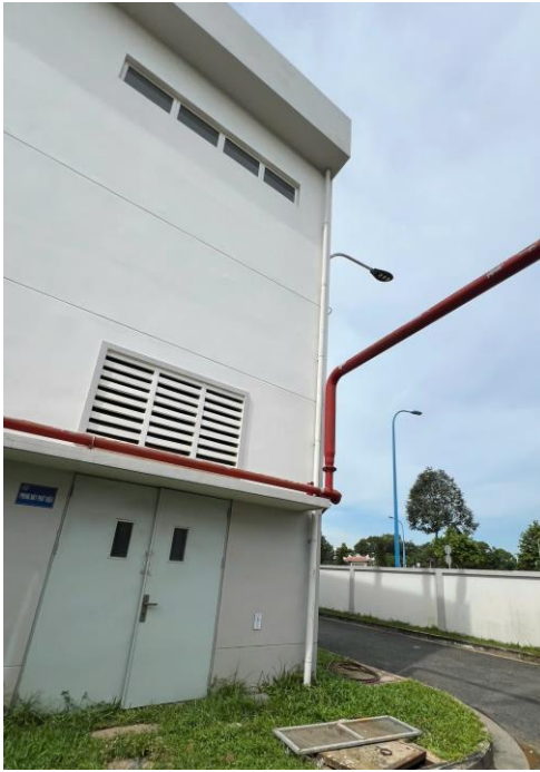
Nước mưa trên mái nhà xưởng
