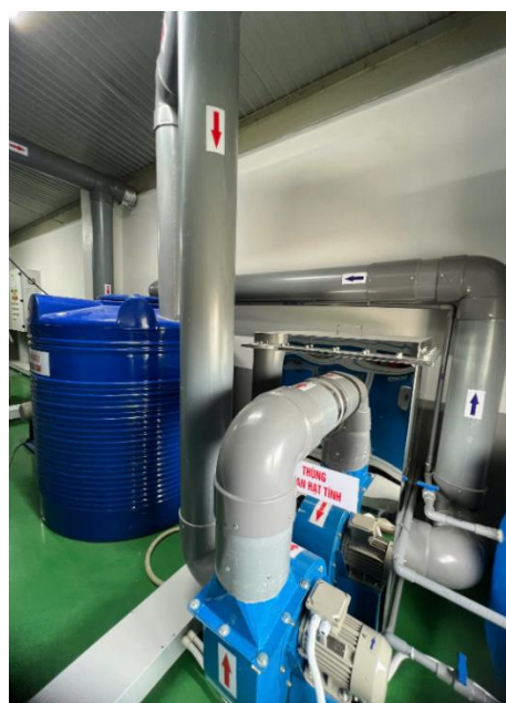
Hình 3. 10. Hình ảnh Hệ thống xử lý khí thải sản xuất thuốc thú y kháng sinh thuộc nhóm Betalactam công suất 1.200 m 3 /h
