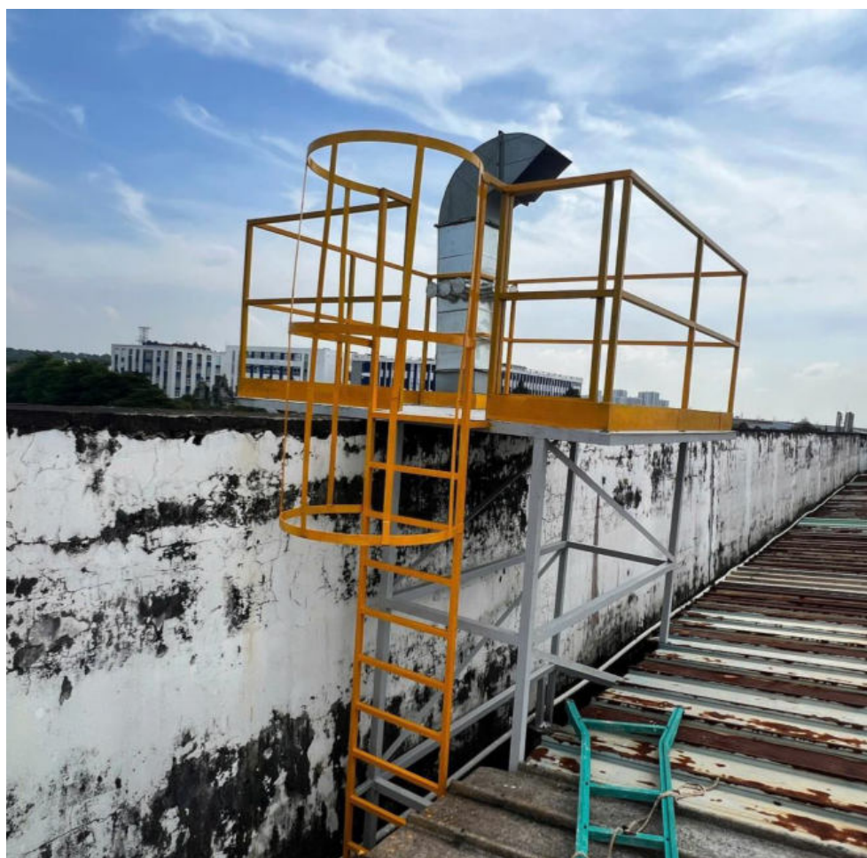
Hình 3.8 Ống thoát khí thải cao 17,6 m so với mặt đất
