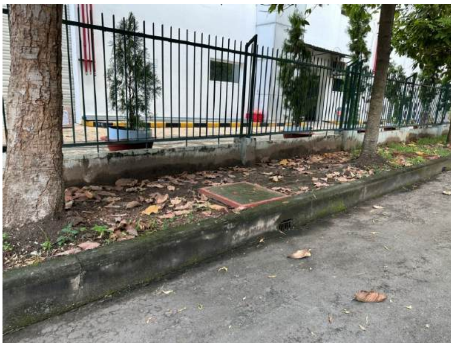
Hình 3.2 Công trình thu gom, thoát nước mưa tại cơ sở.
