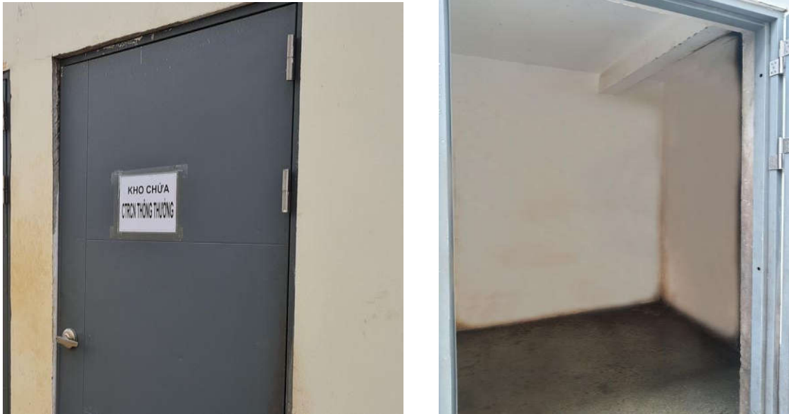
Hình III-16: Kho chứa chất thải rắn công nghiệp thông thường
