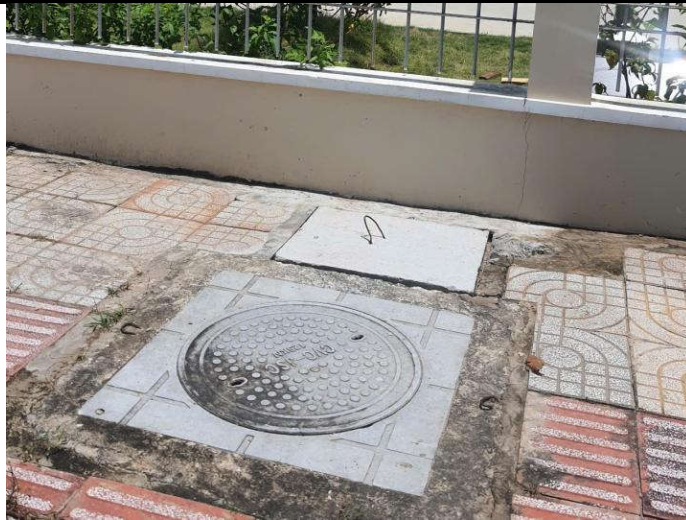
Hình III-6: Điểm đầu nối nước thải với KCNC
