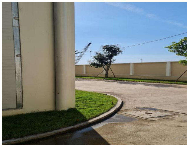
Hình III-2: Hệ thống thu gom nước mưa trên mái của dự án
