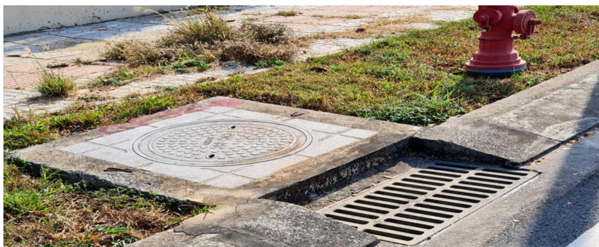
Hình III-4: Điểm đầu nối nước mưa với KCNC
