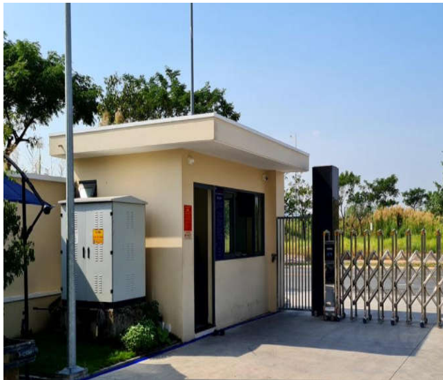
Hình I-26: Nhà bảo vệ của dự án
