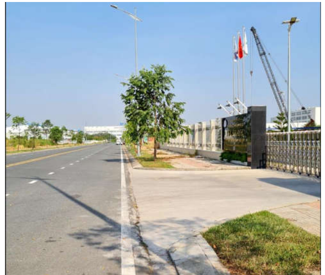
Hình I-27: Hệ thống giao thông bên ngoài dự án: Đường D16
