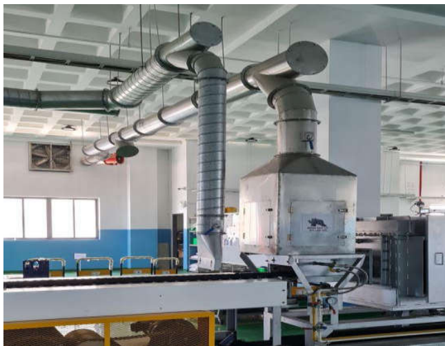
Hình III-13: Hệ thống dẫn khí thải nóng của lò thiêu kết.
