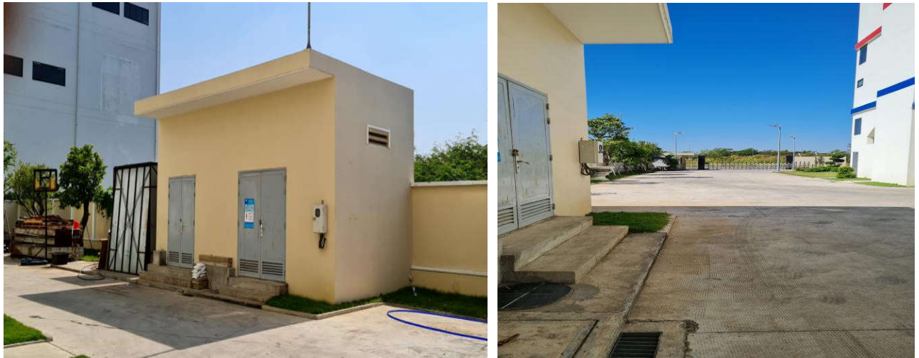
Hình I-28: Nhà cấp điện và hệ thống đường nội bộ của dự án
