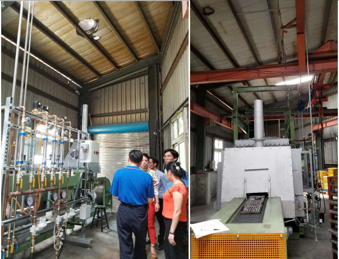
Hình III-22: Hình ảnh xả khí nóng của lò thiêu kết tại Đài Loan, Hàn Quốc
