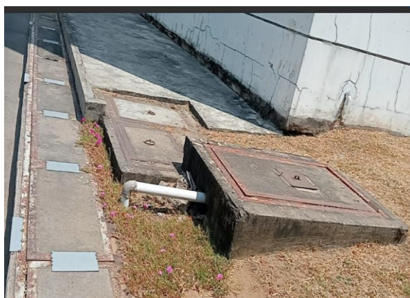
Hình 3.5 Hố gas thu gom nước thải và hố ga đầu nối nước thải với HTXL NT Khu CNC.
