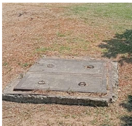
Hình 3.5 Hố gas thu gom nước thải và hố ga đầu nối nước thải với HTXL NT Khu CNC.
