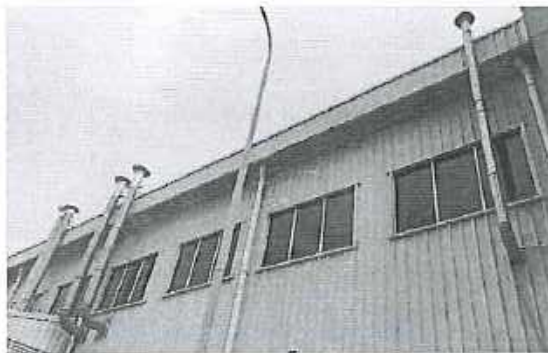
Hình 3.7. Hệ thống xử lý khí thải tại công đoạn hàn
