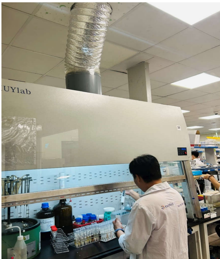
Hình 4.7 Tủ hút mùi, hơi hóa chất và khí thải từ hoạt động nghiên cứu, phân tích của dự án.
