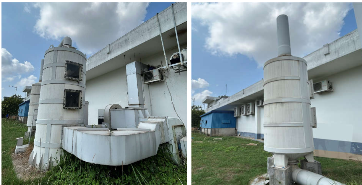
Hình 4.6 Hệ thống xử lý khí thải từ phòng thí nghiệm, phân tích của dự án.
