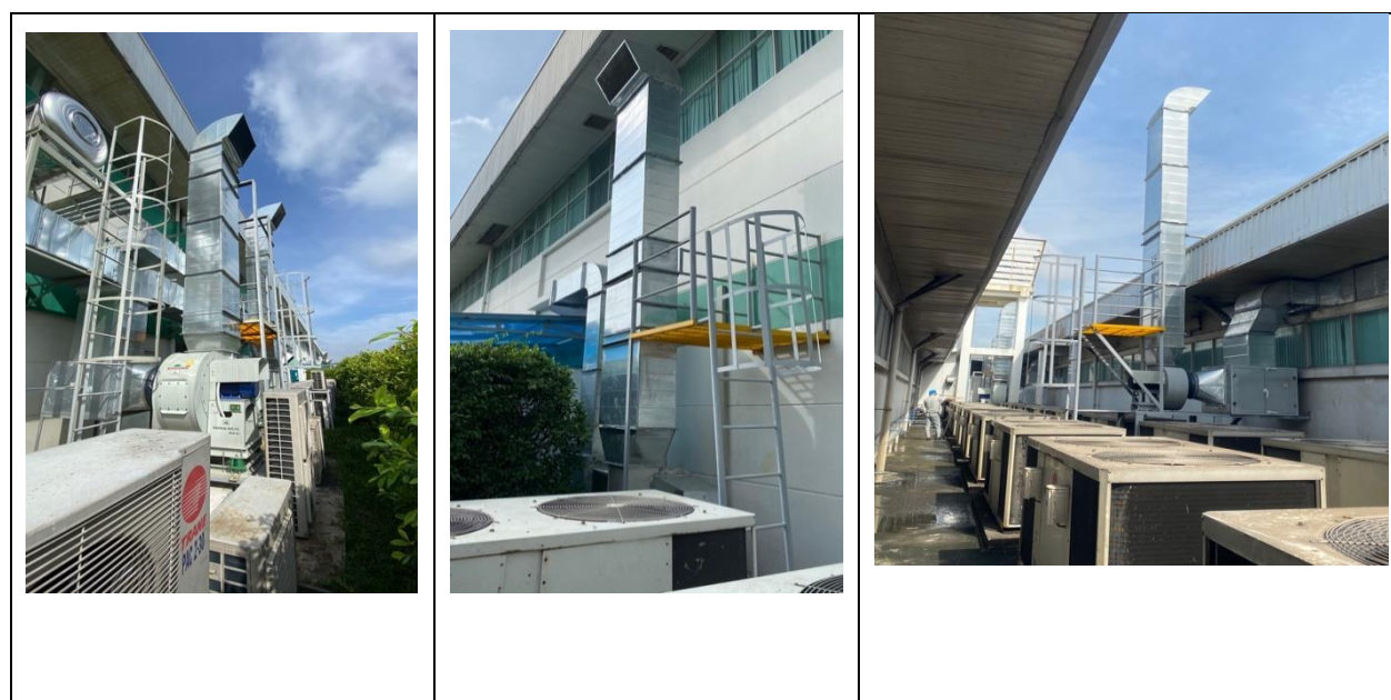
Hình 3.11. Hình ảnh HTXL khí thải từ quá trình tẩy rửa hóa chất, dán keo, sơn, hàn
