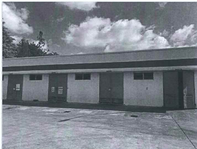
Hình 3.13 Nhà rác công nghiệp thông thường
